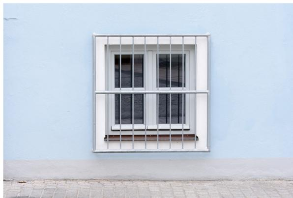
Les barres des grilles en acier doivent avoir une épaisseur de 18 mm et être ancré à au moins 8 cm de profondeur dans la maçonnerie. L'espacement entre les barres ne doit pas dépasser 12 cm.
