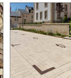
Pavés avec joints
